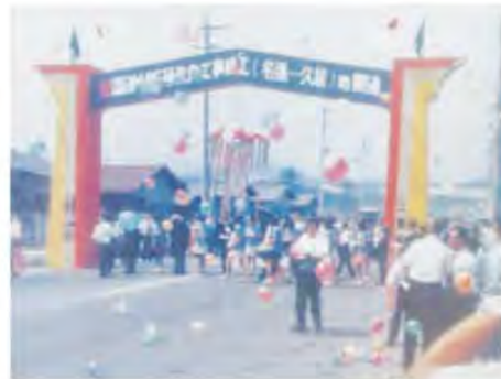
国道165号開通式 津市白山町 橋本 信夫さん 昭和48年7月に全 線開通し、大阪方 面へのアクセスが 便利になりました。
