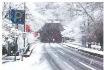
早春の高見トンネル(奈良県側) 松阪市飯高町 北川 文昭さん 雨の多い2月、トンネル付近を訪れると雪に。
